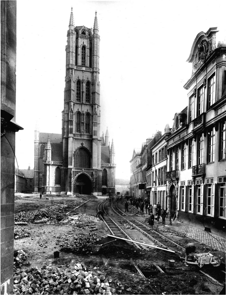
Aanleg sporen in oktober 1898
