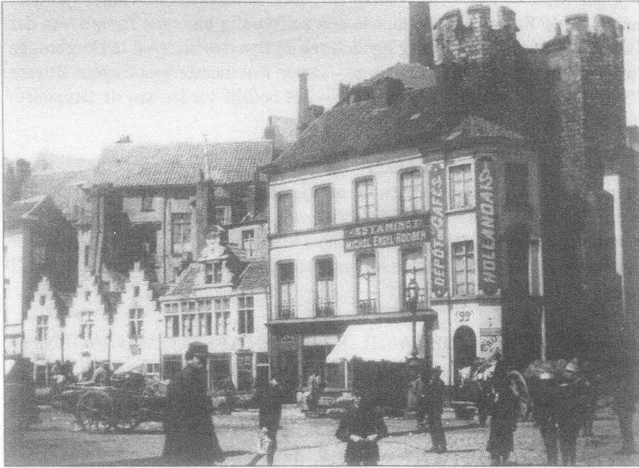
1890 - Zicht op de ingang van het toenmalige Gravensteen aan de Pharaildeplaats (huidig St.-Veerleplein dat toen nog volledig ingebouwd lag). In het Gravensteen zelf huisden verschillende textielfabrieken. Alfred Cnudde en Eugenie Mast woonden er uiterst rechts in het café naast de drie trapevels. Op de originele foto is zijn naam duidelijk te lezen op het raam (foto verzameling Erik Dekeyser).
