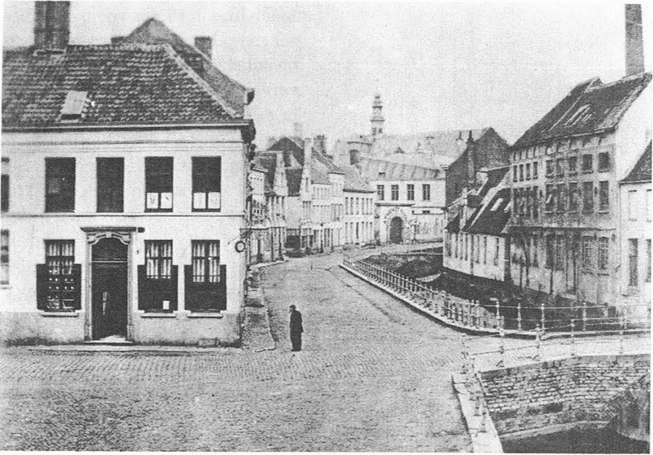
De Ottogracht vóór de demping.
