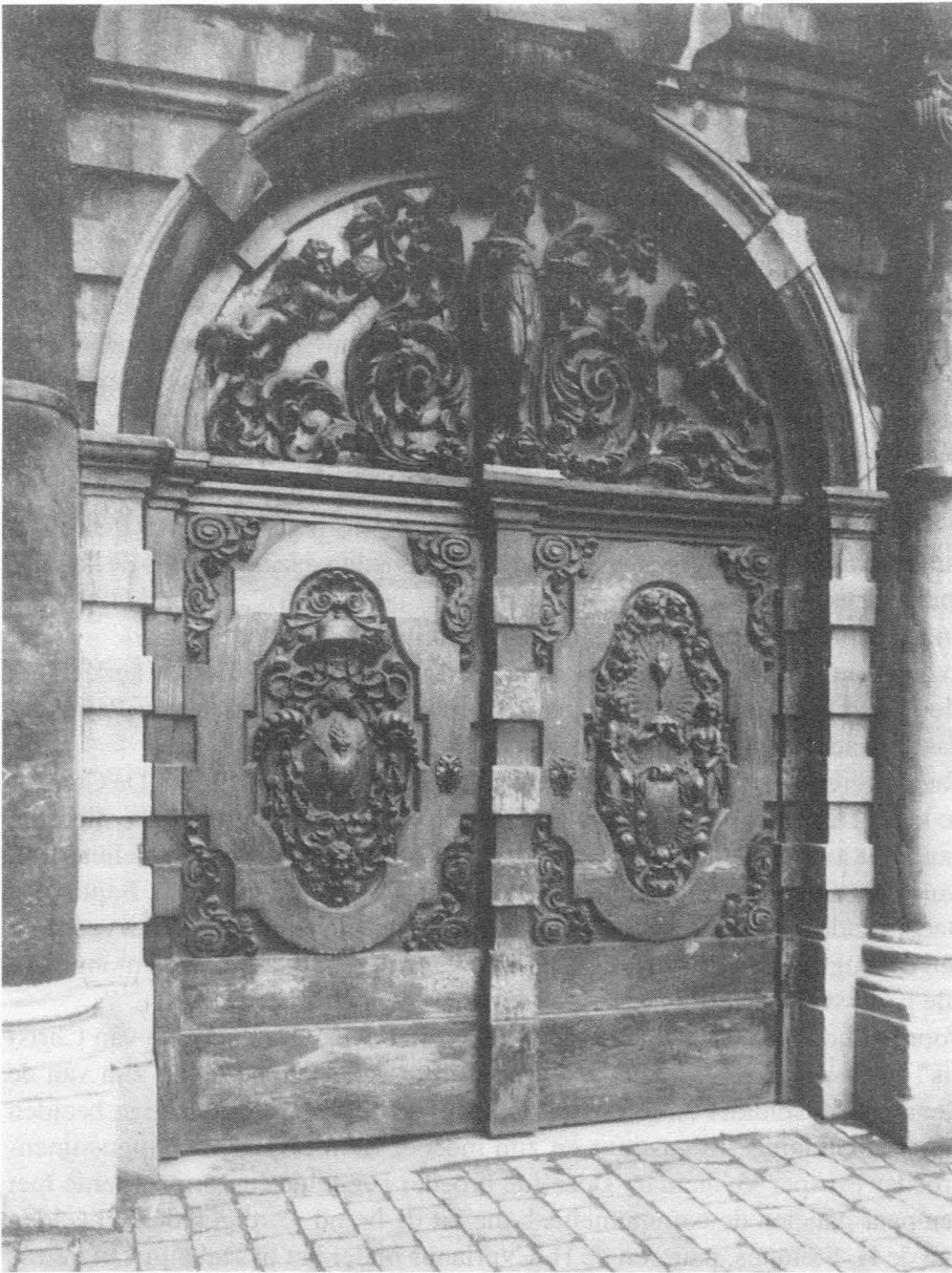
Augustijnenkerk. Detail ingangspoort.
