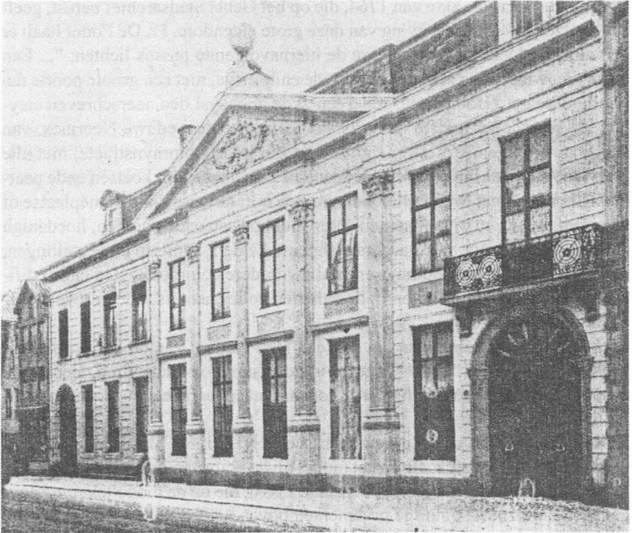
Fig. 34. Hoogstraat "Hotel Reylof", toestand 1907. Foto Bulletin Maatschappij van Geschied- en Oudheidkunde te Gent, 1907.
