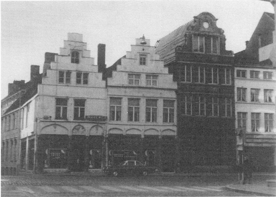
Fig. 3. Hoogstraat, huizen nr. 1, nr. 3, nr. 5 (vóór de restauratie van dit laatste in 1977-1978) en nr. 7. Foto architect W. Govaerts, 1976.
