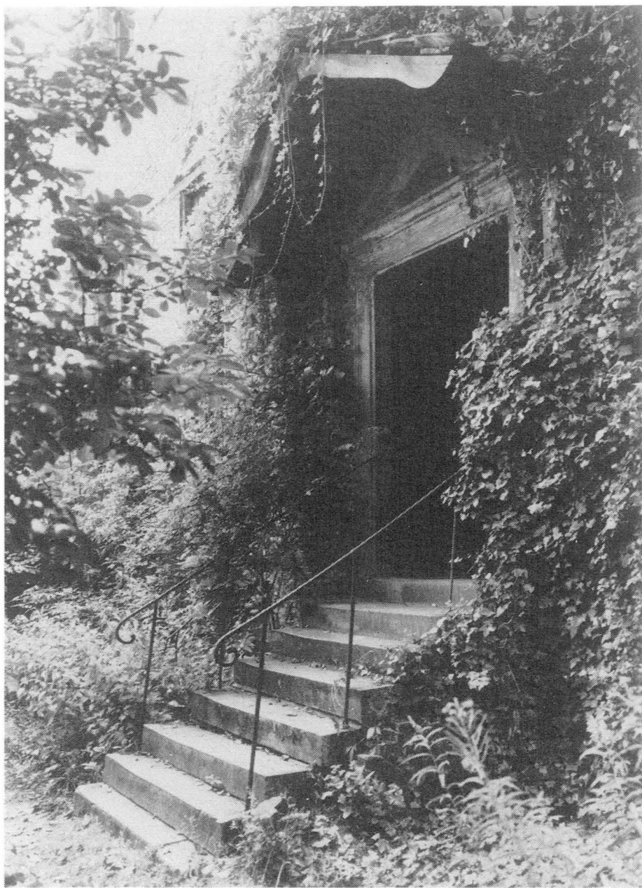
De ingang van de oude Infirmierie. Een verborgen pareltje in het Patershol dat afgesloten werd door een poort in de huidige Trommelstraat.
