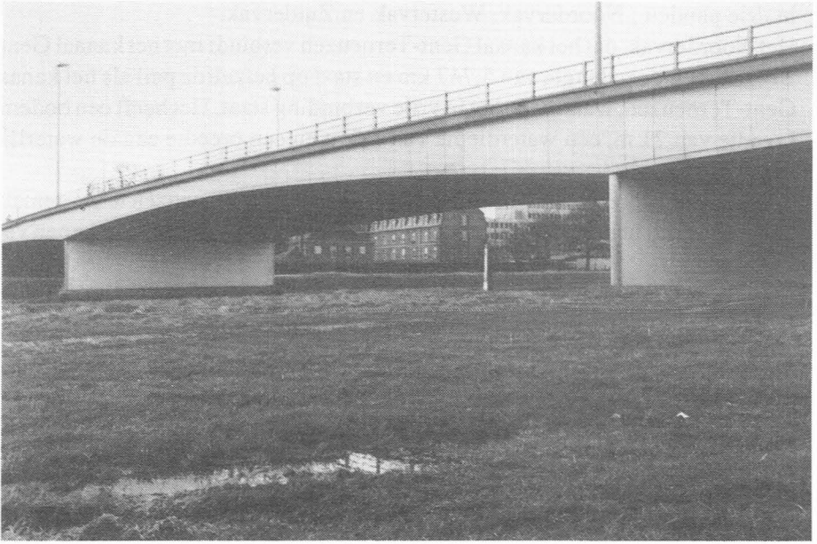
Ringvaartbrug W.7 - Maaltebrug.
