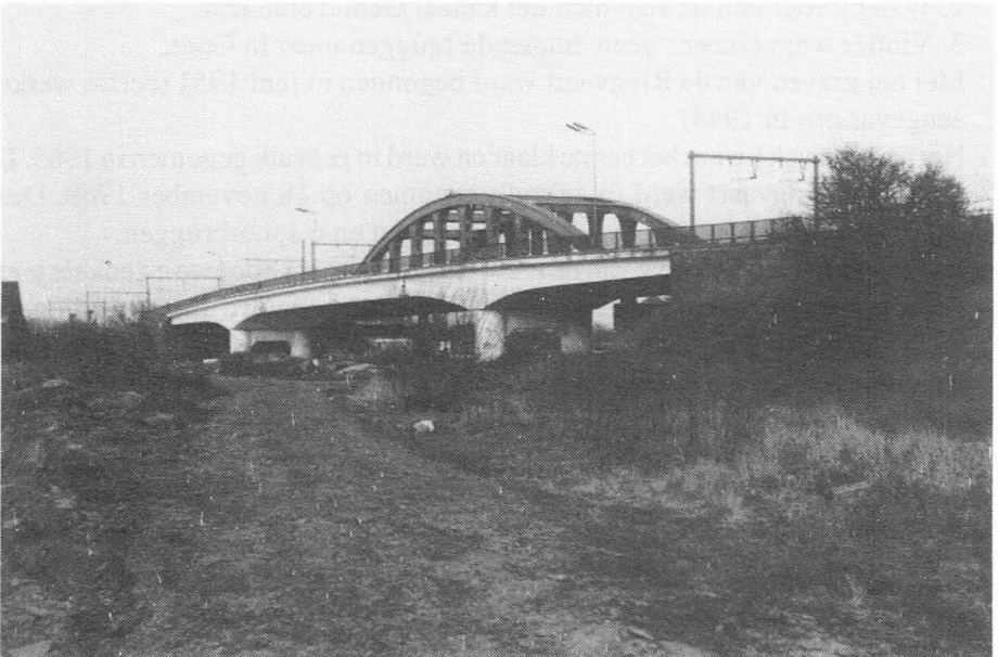
Ringvaartbrug W.6-S.2. - Buchtenbrug.
