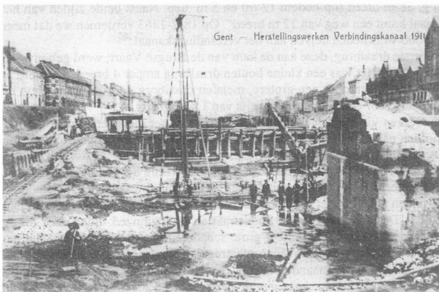
Het bouwen der kaaimuren, in 1900, langs het verbindingskanaal kostte 210.000 fr. waarvan 110.000 fr. door de staat betaald.
