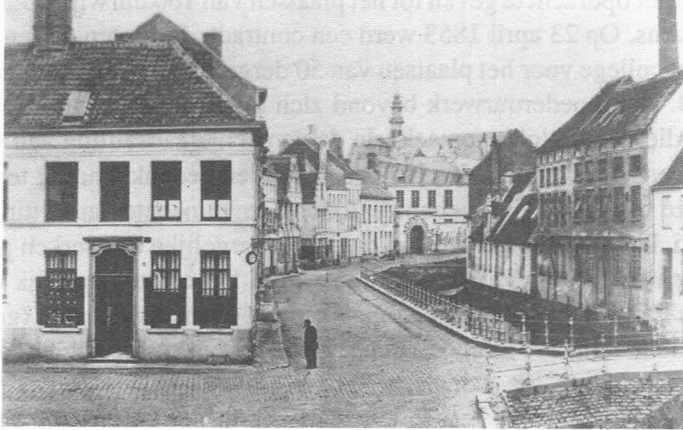
Hoek Ottogracht-Goudstraat. Stadsuurwerk dat waarschijnlijk dateert uit 1853-1854.
