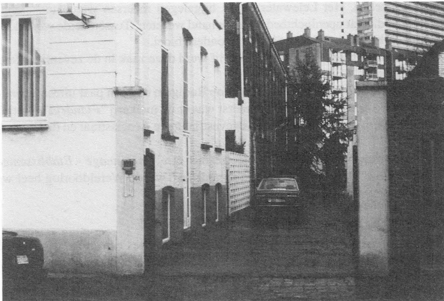
Foto 23. Vroegere textielfabriek Fiévé - Tollenaere (Drongensesteenweg).
