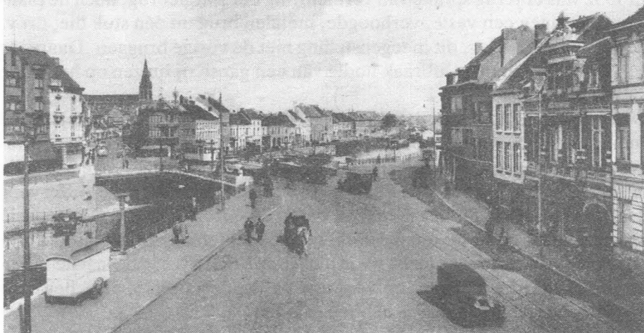
Gand. — Rue du Nord et pont de la Barge Gent. — Noordstraat en Bargebrug Ghent. — North street and Barge-Bridge
