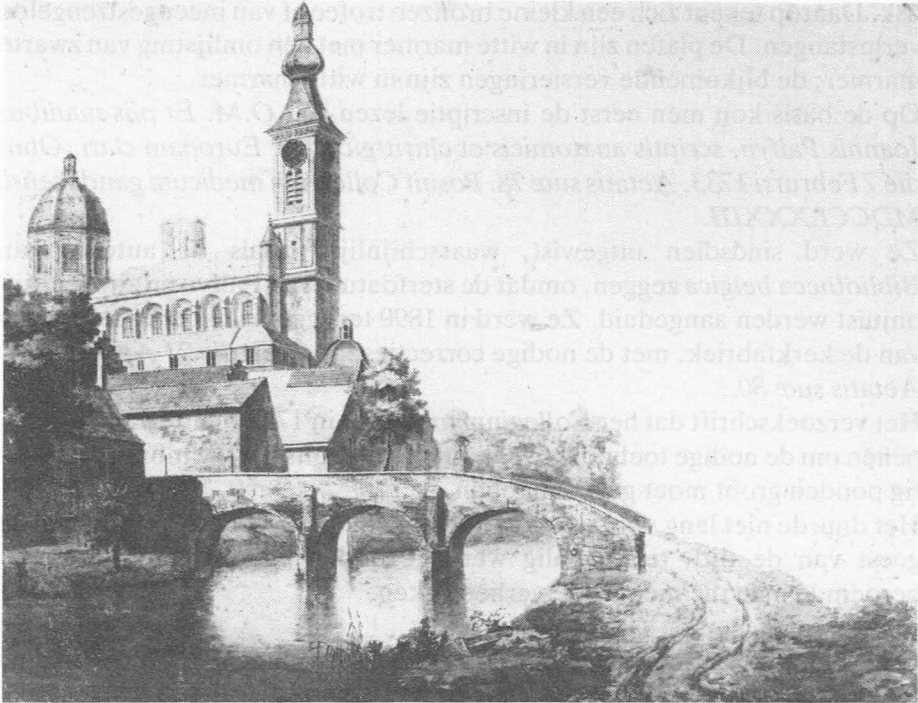
Deze gefotografeerde tekening uit het atlas Goetghebuer toont ons de Muinkbrug voor 1840. Bij de tekening zijn de volgende maten aangeduid : brugopeningen : \pm 20 voet, lengte 90 voet en breedte 10 voet. De vrije hoogte onder de middenste boog : 28 voet.
