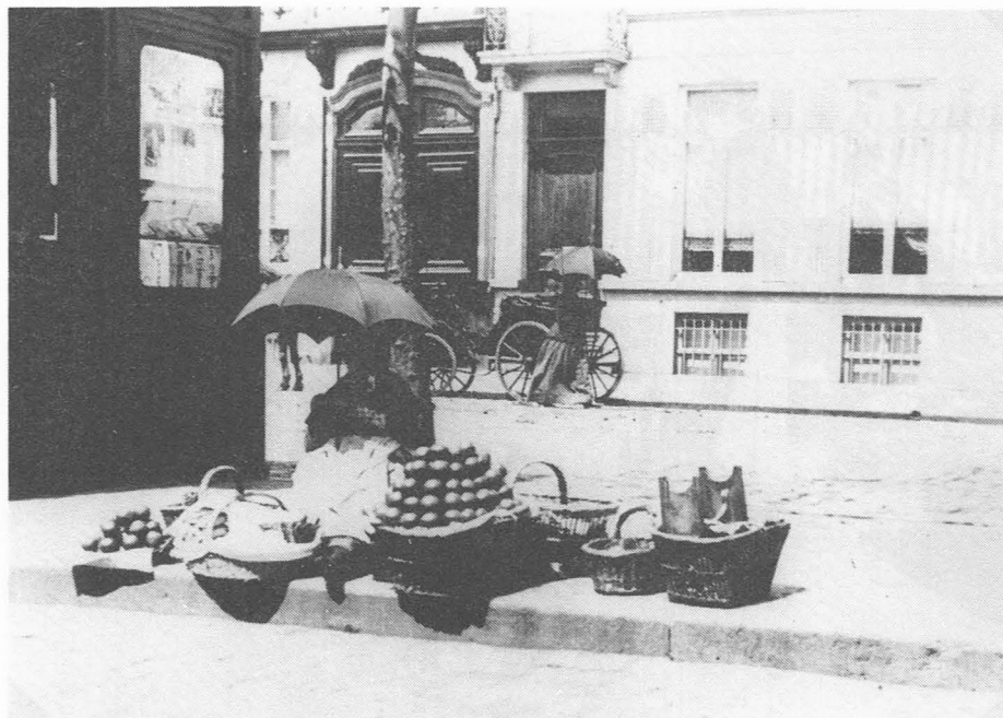
Fig. 7. Fruitverkoopster naast de krantenkiosk op het Graaf van Vlaanderenplein voor het voormalige Zuidstation. De verkoopster zit op een stoeltje met afgezaagde poten, beschermd door een paraplu tegen de felle zon. Men kon hier fruit en andere versnaperingen kopen om uit het vuistje te nuttigen. Een huurrijtuig wacht op klanten. (Fonds Vanderhaegen - Verzameling Museum voor Volkskunde te Gent)
