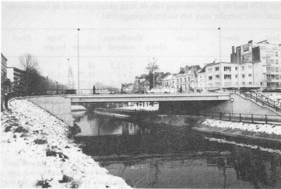
De huidige Terplatenbrug gezien vanaf de Stropkaai (foto 1980).
