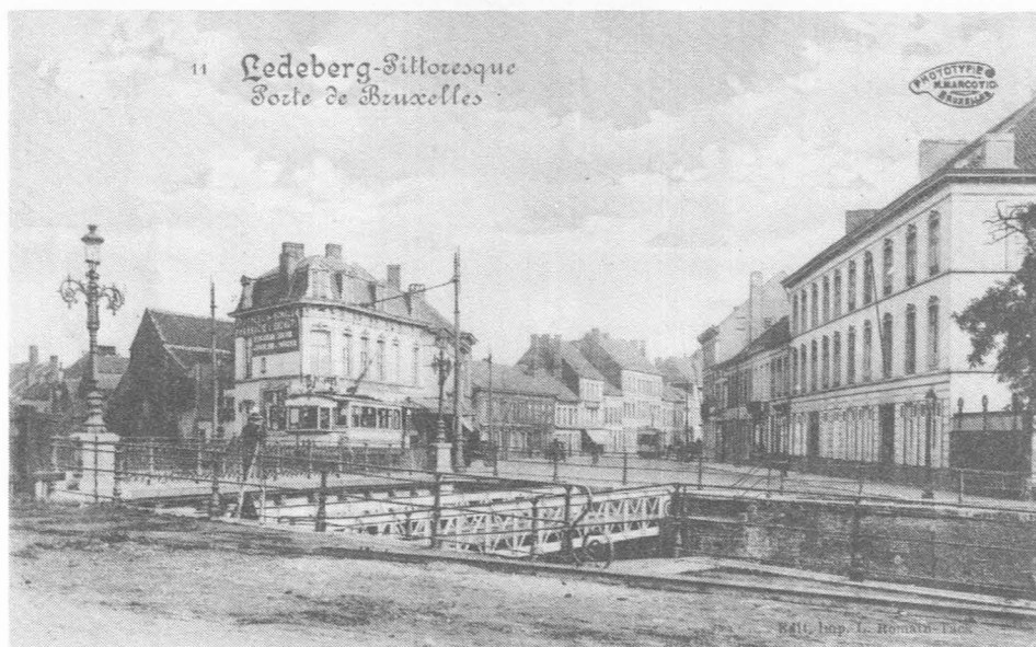
De tweede brug over de Franse Vaart.
