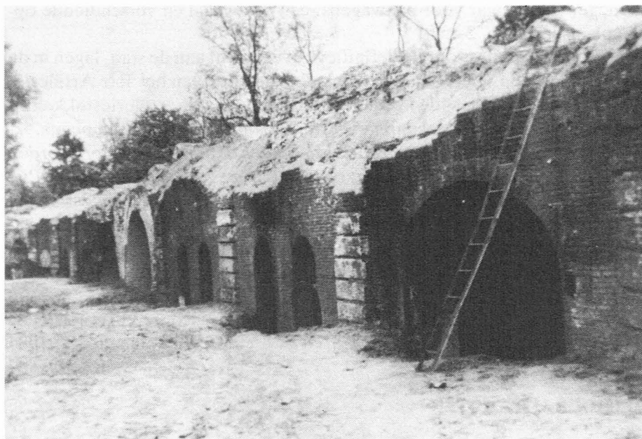
Afb. 8. Zicht vanaf de binnenplaats op de binnenwal. De opening onder de ladder is een toegang naar een der centrale gangen. De kleinere openingen zijn vensternissen van gelijkvloerse kamers. (Foto : Van Wesemael 1950)
