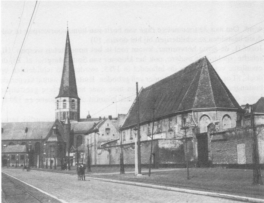
Afb. 2. De kapel van 1611. De toren afgebroken in 1903. Ogiefvensters toegemets in 1903. Op de achtergrond de kerk St.-Martinus.
