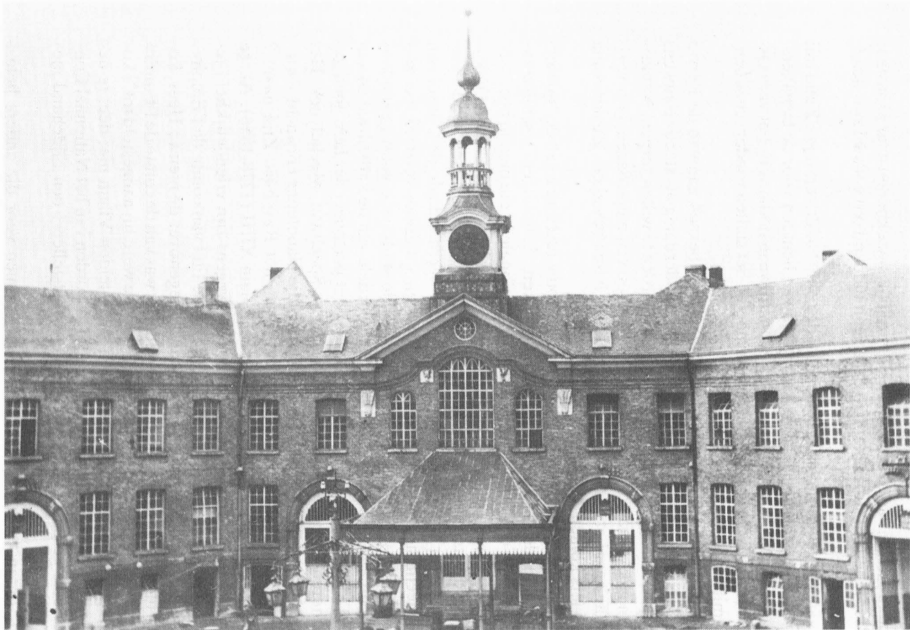
Afb. 8. Vleugel met kapel, die 3 van de 7 traveeën inneemt. Bemerkt het slank klokketorentje met zijn wijzerplaat. De overdekte stoep zal wel aangebracht zijn om de lijkwagens te laten verwijlen. Copyright Comm. Mon. & St.
