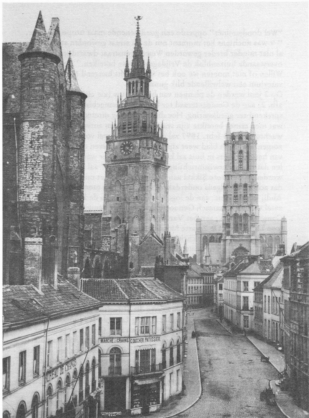
De "Catalognestraat" vóór 1890. Op de voorgrond links, tussen de huizen "Bureau de Change" en "Marché aux Grains" bevindt zich een zij-ingang van de kerk. Onderaan rechts het voormalig Metselaarshuis (het huis met het bordes voor de gevel). In 1852 werd de oorspronkelijke gevel van 1527 onmeedogend verwoest. Dank zij bewaarde afbeeldingen van het gildehuis gelukte men er in 1912 in de gevel te herbouwen aan de Graslei. Op de achtergrond de beruchte St.-Jansstraat. (Foto J. van Waesberghe, Copyright A.C.L. 25985 B.)
