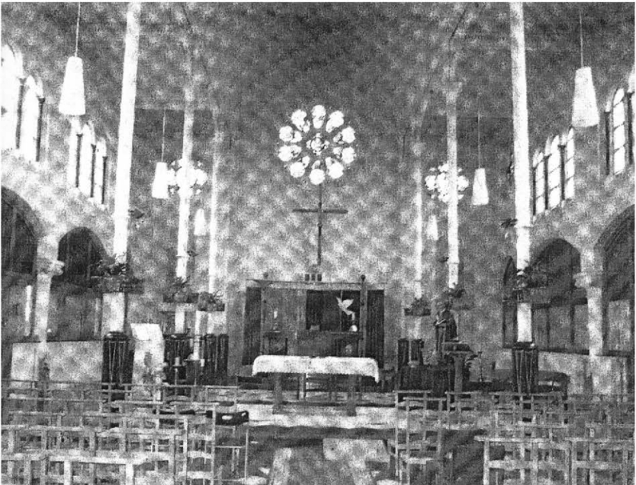
Kapel van 't Strop. Let op de witte gietijzeren pijlers.
