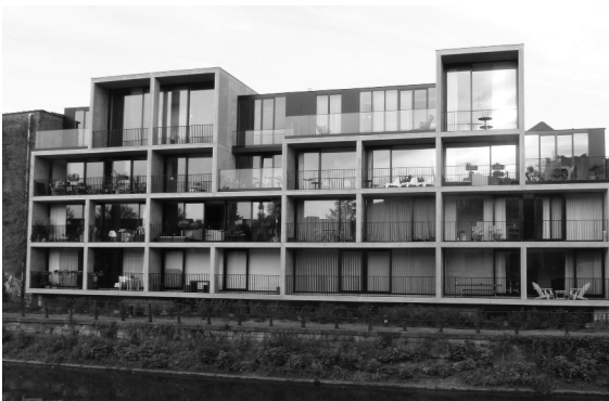
Dit appartementsgebouw aan de achterzijde van huizen aan de Ham keert zijn open gevel naar het water. Het vervangt een oud magazijn met gesloten gevel (foto genomen van op de Baudelokaai, 2013).
