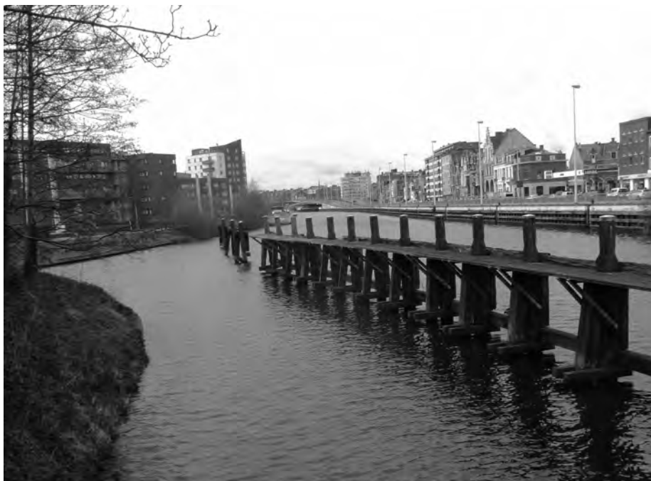
Afb. 6. De ‘platen’ van het Heirmissas (foto 2014). Loopplanken en er boven uitstekende ‘proppen’ om aan te meren en ook fungerend als afbakening van de vaargeul. In de verte palen zonder ‘platen’ die de toegang tot de zijarm van het sas afsluiten. De platen zijn breder dan deze van Ter Platen uit 1407 en niet bovenaan, maar opzij van de palen bevestigd.
