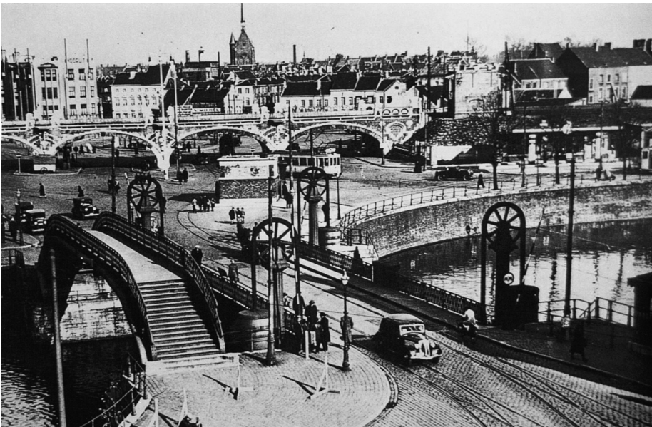
Brug met passerelle aan de Dampoort (ongedateerde foto, verzameling onbekend) van een type dat nu nog te zien is aan de Lousbergskaai, gelukkig bijna altijd in neergelaten toestand.
