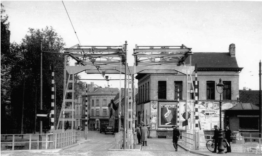
Contributiebrug aan de Coupure (ongedateerde foto vermoedelijk uit de jaren 1950 genomen aan het begin van de Nieuwe Wandeling en met de Begijnhoflaan in de achtergrond, verzameling DSMG, schenking Huguette de Bleecker).
