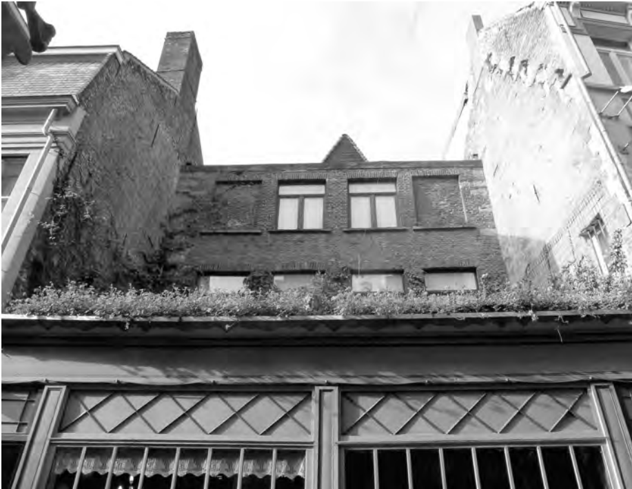
Afb. 6. Neplijstgevel (foto genomen vanuit de Jan Breydelstraat in 2015) met blinde vensters op de bovenste verdieping en daarboven uitstekend: de top van het dak dat vermoedelijk nog zijn oorspronkelijke vorm heeft. Typisch voor heel oude daken is de erg steile dakhelling.
