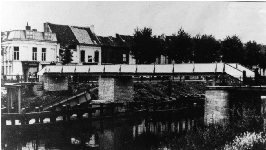
Noodbrug over de Brugse Vaart ter vervanging van de door het Belgisch leger in mei 1940 opgeblazen Hamerbrug. ('Zwarte Doos' Gent)
