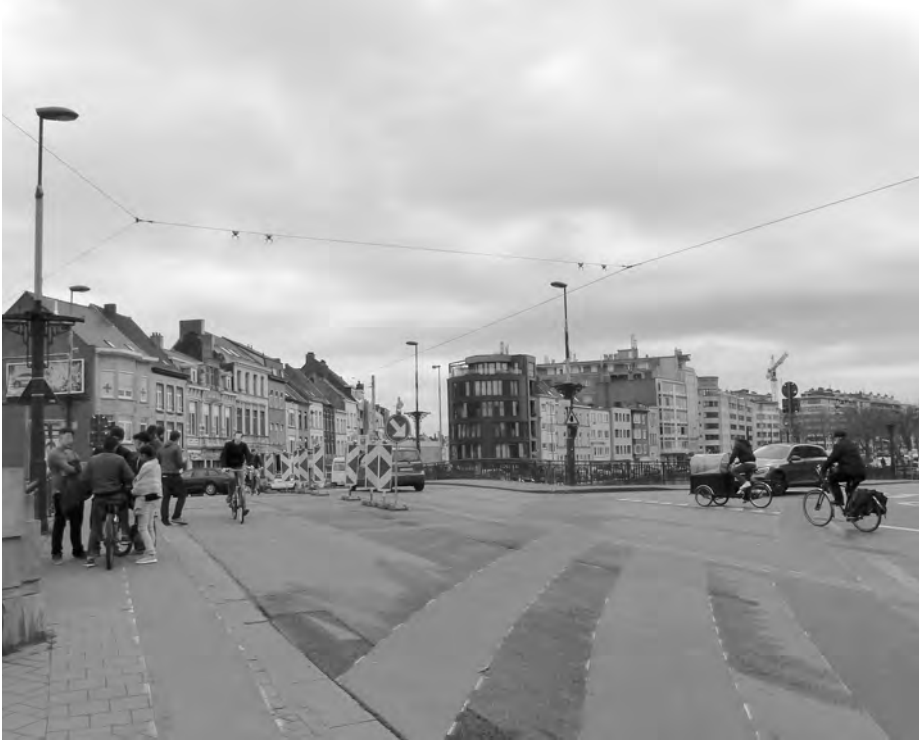
Afb. 7. De Bargiebrug net voor het in werking treden van het circulatieplan (GT foto genomen vanuit de Zuidkaai bij de Phoenixstraat, eind maart 2017). De knipstrepen zijn goed zichtbaar, enkele versperringen werden al aangebracht, maar auto's rijden nog samen met (bak)fietsers de brug op.
