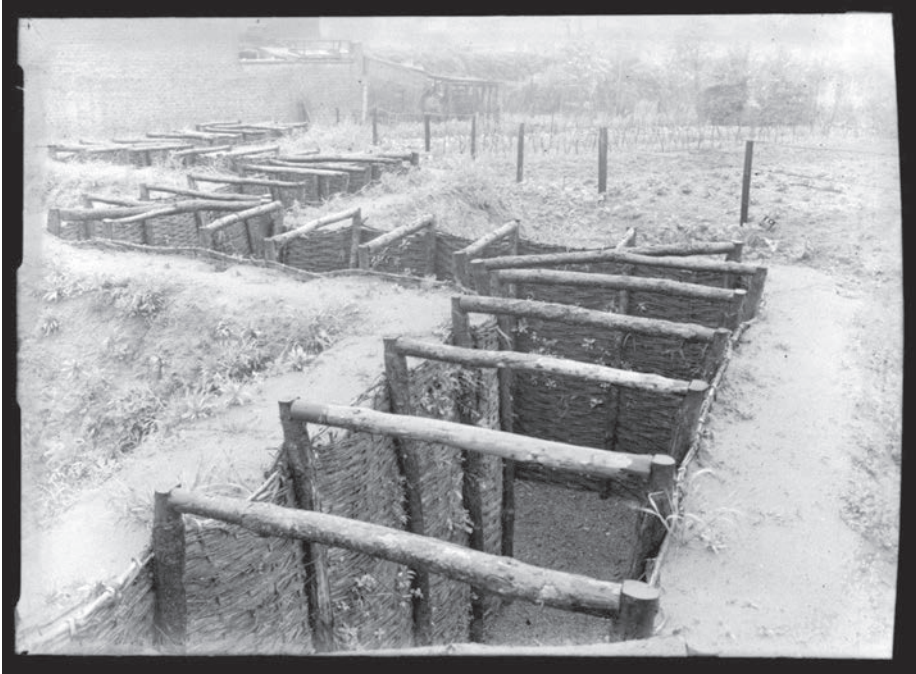
Afb. 1. Op deze foto (Edmond Blochstaat, Gentbrugge, verzameling Georges Antheunis) is goed te zien hoe de schuilloopgraven in zigzagvorm konden aangelegd worden. De wanden bestaan uit rieten of wissen matten ondersteund door verticale en horizontale houten palen tegen inkalven.
