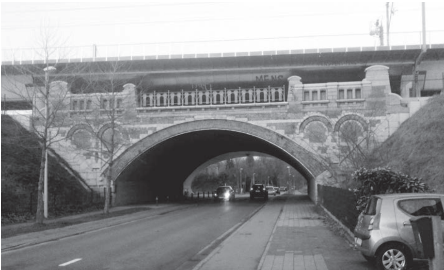
Afb. 19. Aan de zijde naar Sint-Denijs van de Sneppebrug werd de oude brug op een slimme manier geïntegreerd in een constructie die de oversteek van de Leie mogelijk maakt voor fietsers en voetgangers. De spoorbrug zelf ligt een eind hoger (foto 2017). Aan de stadszijde vertoont de nieuwe Sneppebrug een fraaie sobere boog. Dit alles naar ontwerp van arch. Ph. Samyn en partners samen met Infrabel (NMBS).
