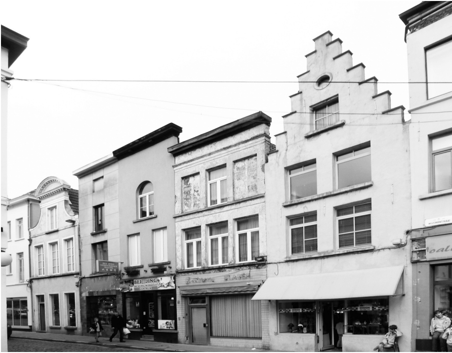
Afb. 2. Een gedeelte van de noordelijke straatwand (foto 2014). Het Minnemansteegje lag iets meer naar links (buiten beeld). Bemerkt de bovenpartijen van de gevels die de vorm van de oorspronkelijke tuit- of trapegevels verraden.
