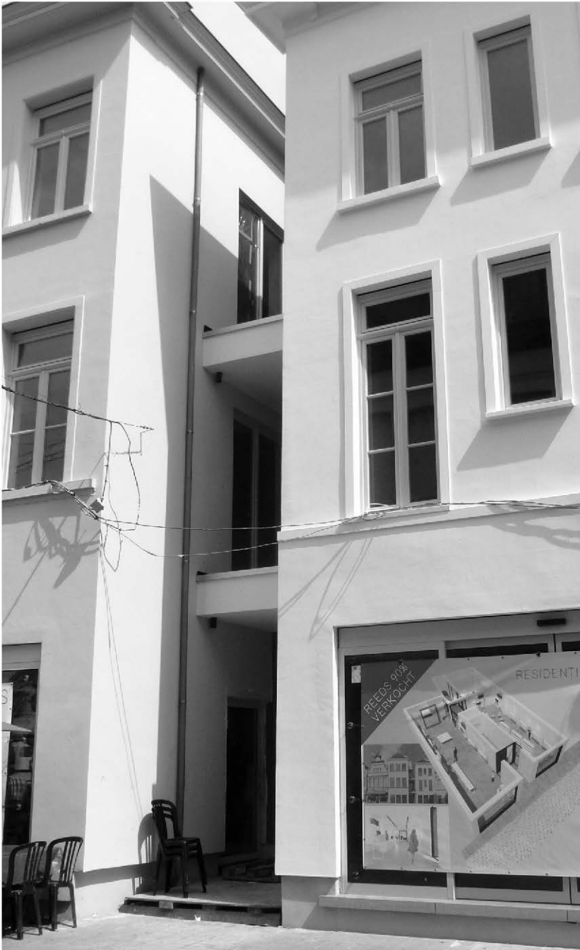
Afb. 5. Geveluitzicht na de recente ingrijpende verbouwing. De vroegere steeg is perfect herkenbaar (foto 2014). Ook de rooilijn verspringing is nog aanwezig.
