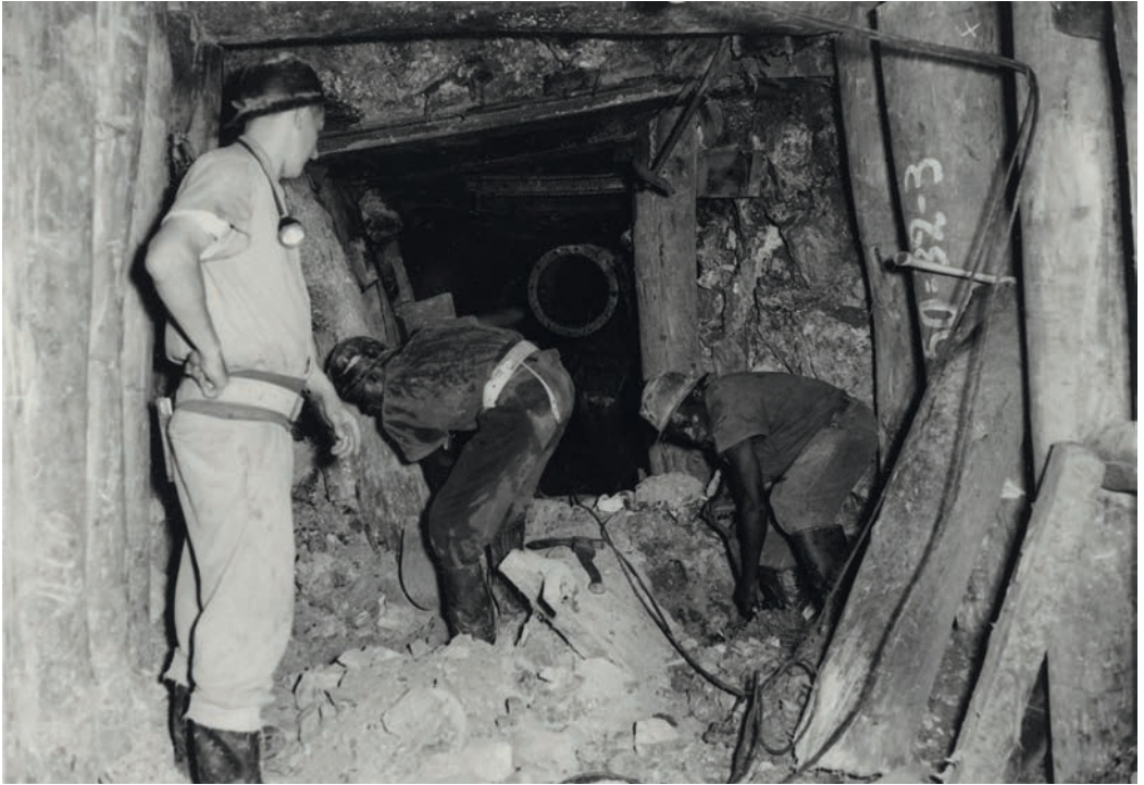
De Mine Prince Leopold. Foto: UMHK, 1957 (HP.1984.25.110-70, collectie KMMA Tervuren, © KMMA Tervuren)
