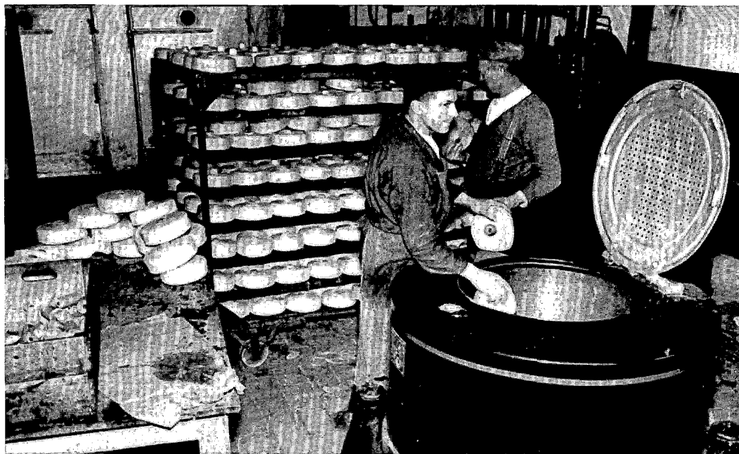
Verven van bobijnen in een textielfabriek
