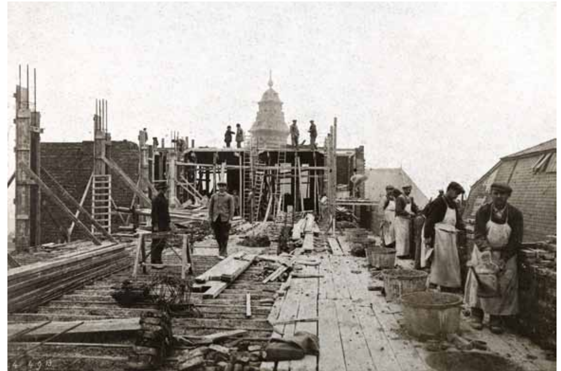
Metselaars bij de bouw van het Volkshuis in Brussel, eind 19e eeuw. (Amsab-ISG, Gent)
