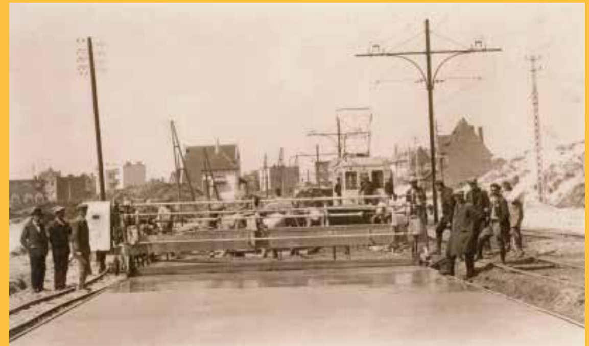
Aanleg van een nieuw stuk Koninklijke Baan aan de westkust tijdens het interbellum. (Heemkundig centrum De Benne, Blankenberge)
