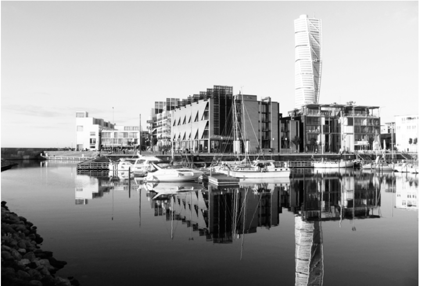
Westelijke Haven in Malmö. Foto: Guy Baeten
