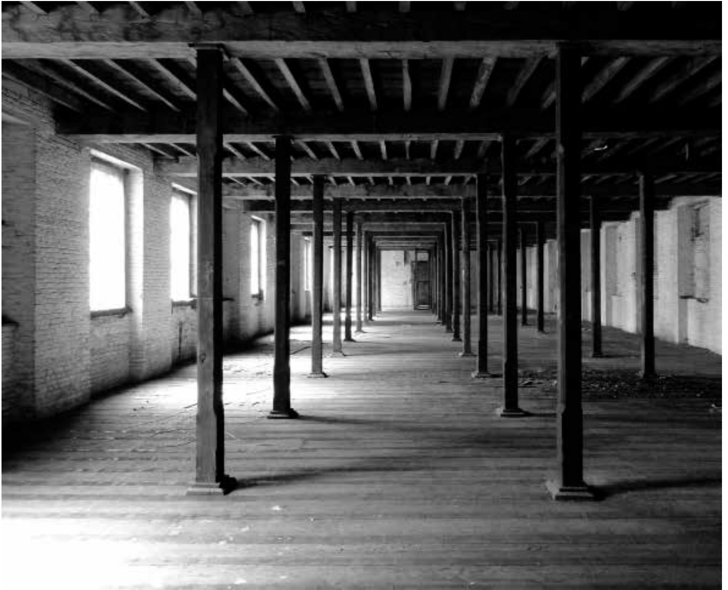
Brussels pakhuis met houten draagstructuur van 1829. Foto: Louis Vandenabeele
