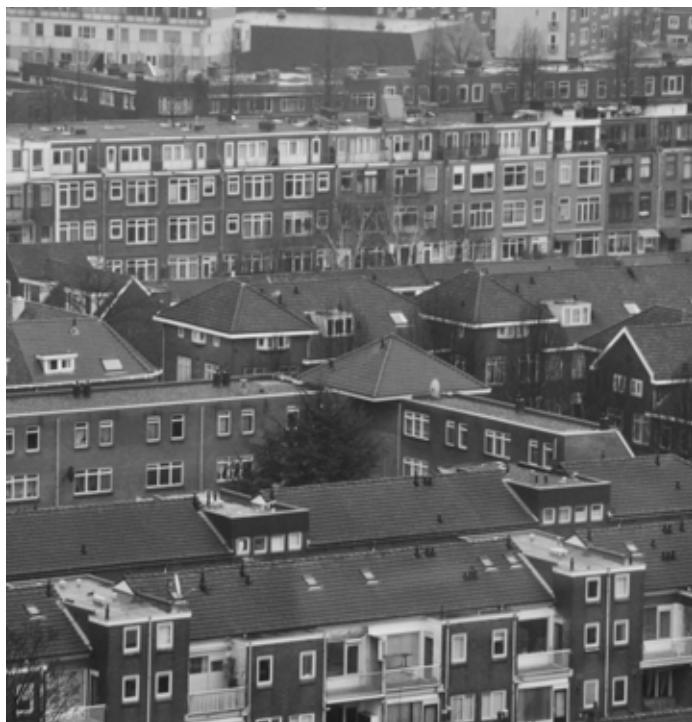
Van bovenaf is de hoge bebouwingsdichtheid in Schiedam-Oost goed te zien
