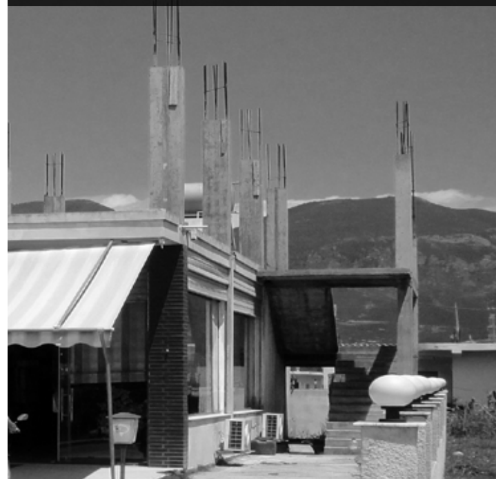
Door de uitstekende stalen staven is het altijd mogelijk om het restaurant uit te breiden, als de zaken goed gaan.
