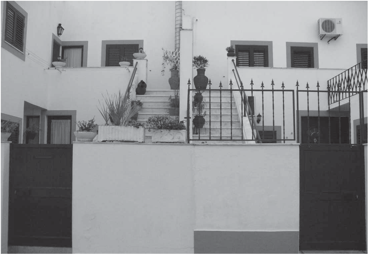
Aanpassing van het oorspronkelijk ontwerp: trappen naar terrassen op de eerste verdieping.
