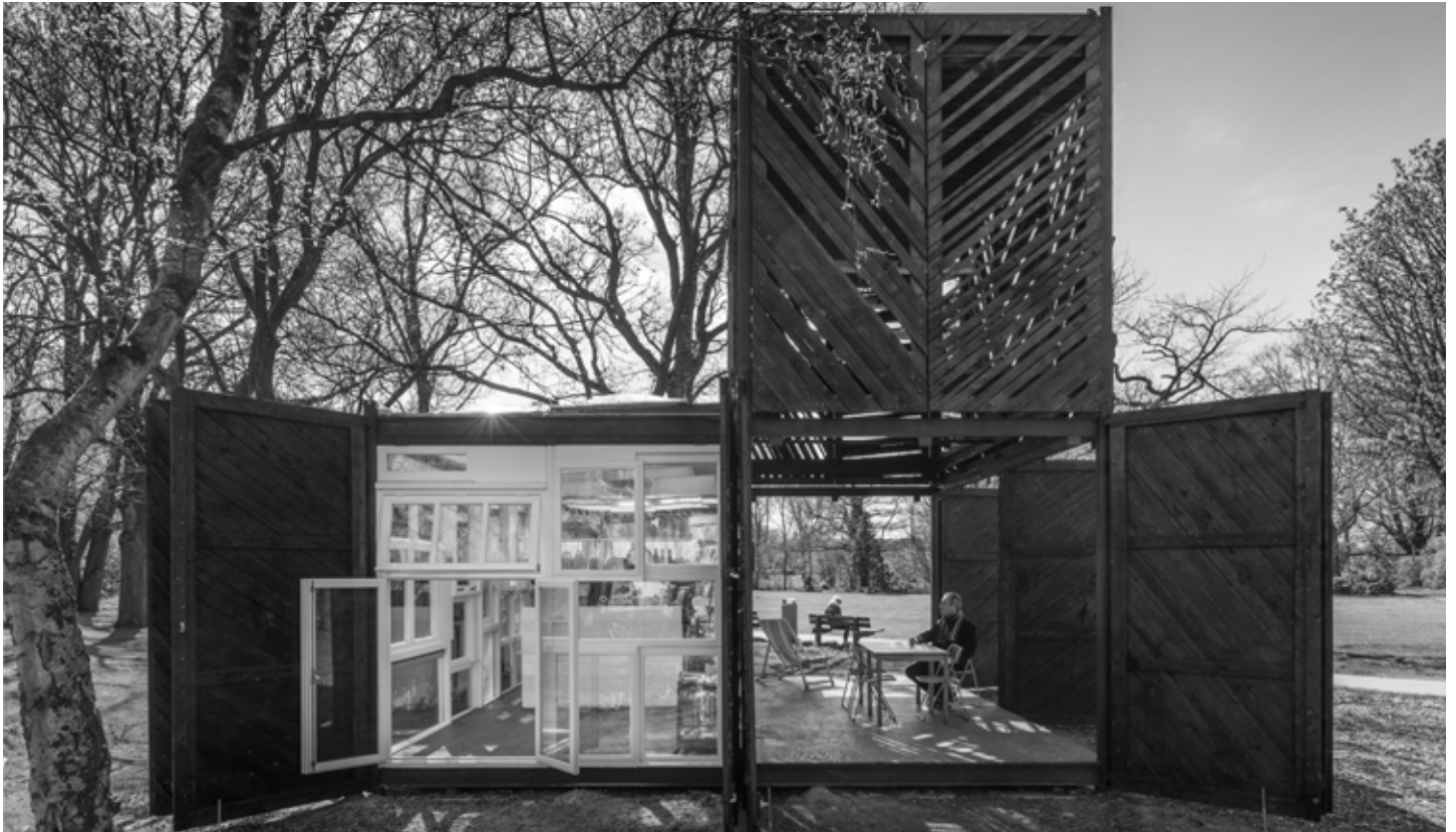
Architectenbureau SLA ontwierp met de Noorderparkbar een culturele ontmoetingsplaats voor Amsterdam Noord.
