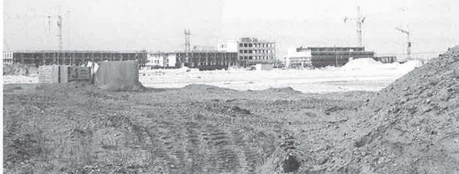
De Amsterdamse wijk IJburg in aanbouw.
