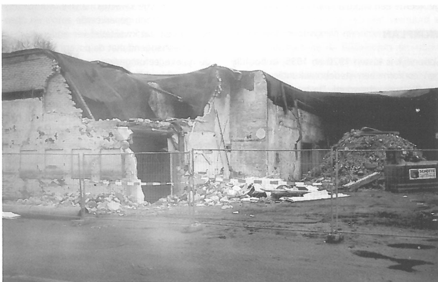
Sommige panden op bedrijventerrein Waalhaven-Zuid zijn hard aan vervanging toe. Foto: Marco Bontje
