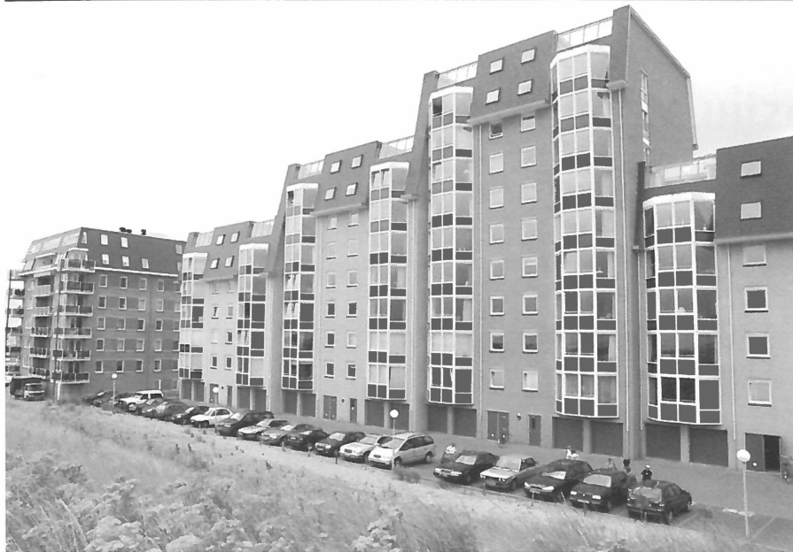
Appartementencomplex vlak tegen de duinenrij in Cadzand-Bad (Bron: Peter Verdurmen)
