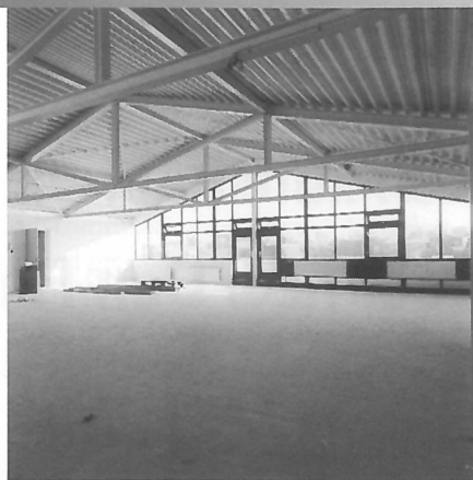
Concordia, Hoge Zand in Den Haag, is een tot atelierriimte verbouwd voormalig kraakpand (Foto Rob Kollaard)
