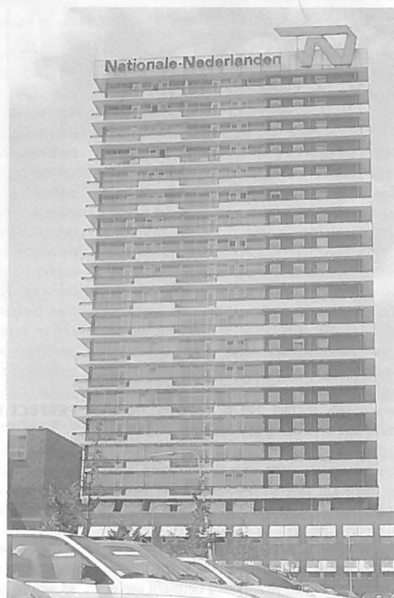
Haalbare renovatie in Utrecht.
