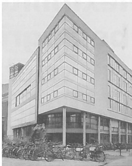
De Theaterschool heeft een plekje in het centrum kunnen behouden. Foto: Dienst Ruimtelijke ordening Amsterdam
