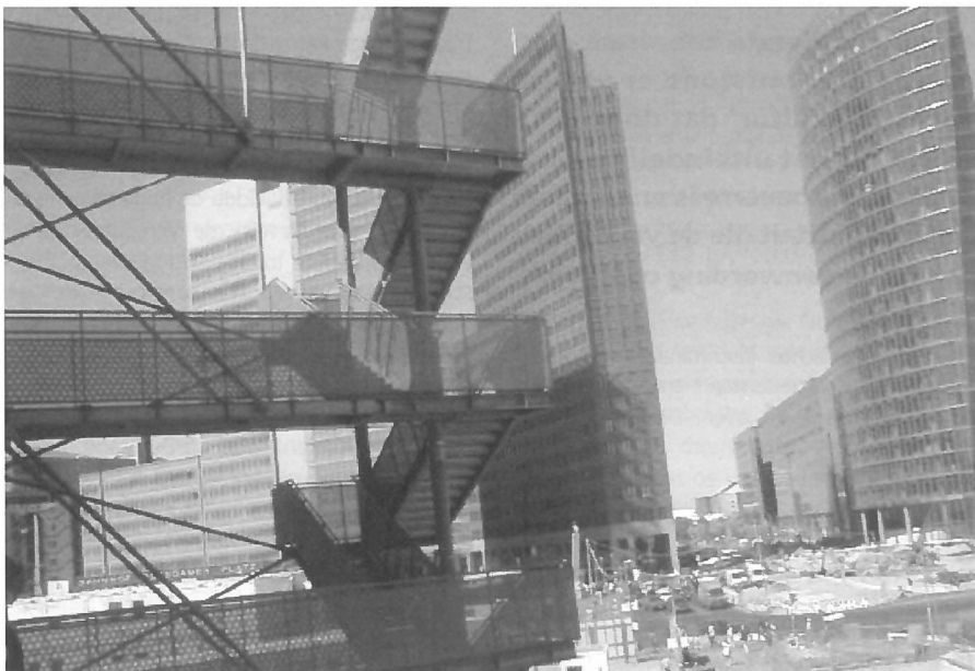
Het nieuwe Postdamer Platz in aanbouw (Bron: auteur)
