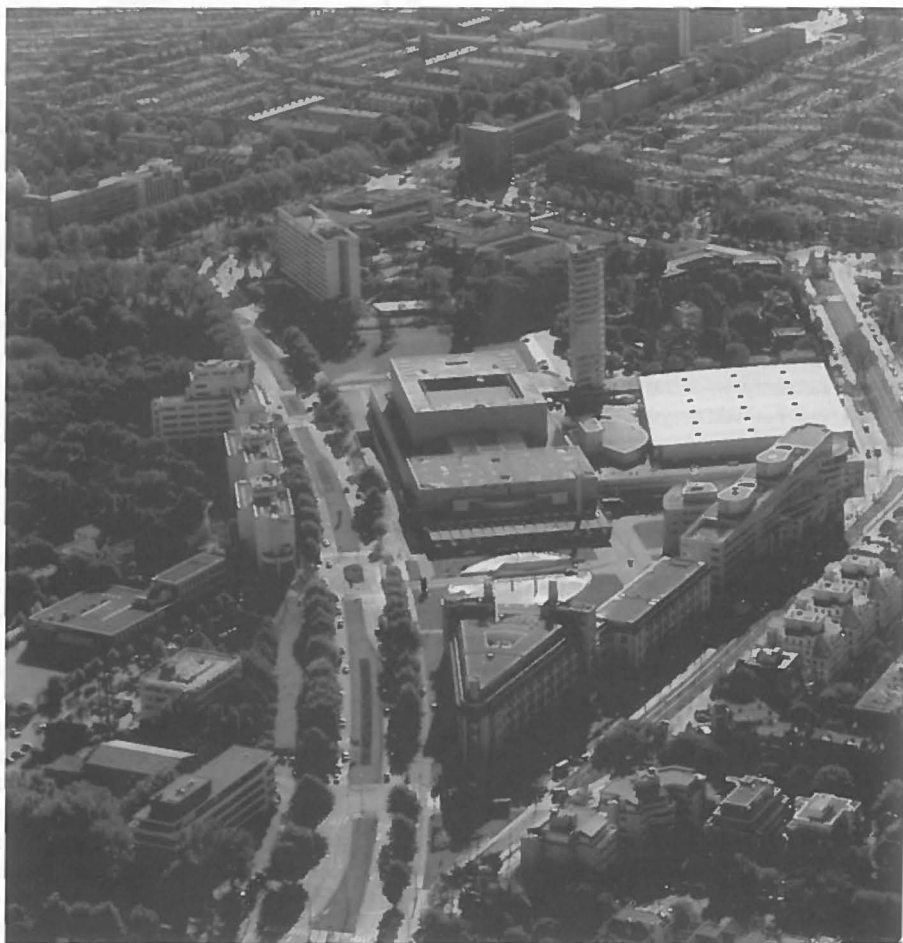
Typische C-locatie met kantoren: het Congressgebouw. Bron: gemeente Den Haag
