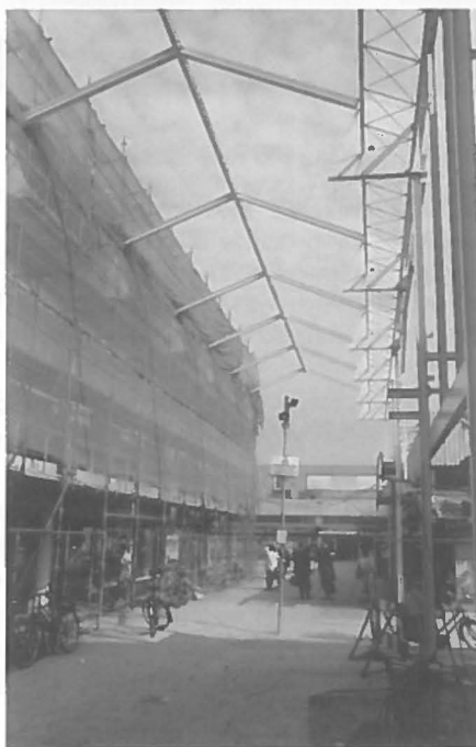
Renovatie van winkelcentrum Overvecht te Utrecht. Foto: Ronald Klip.
