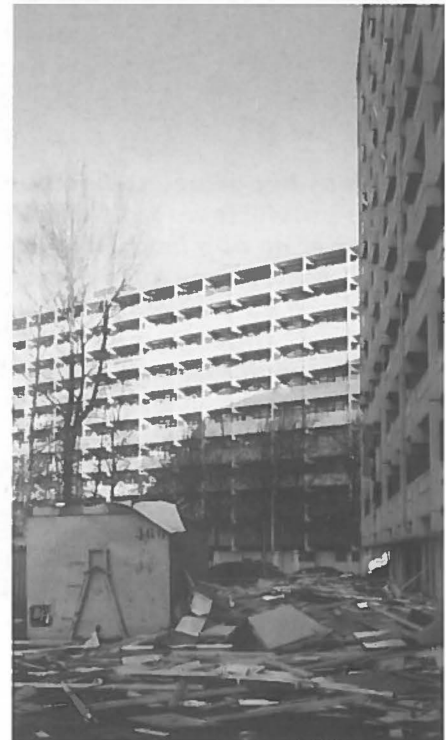
De sloop is begonnen. foto: Dorien Kasteleijn
